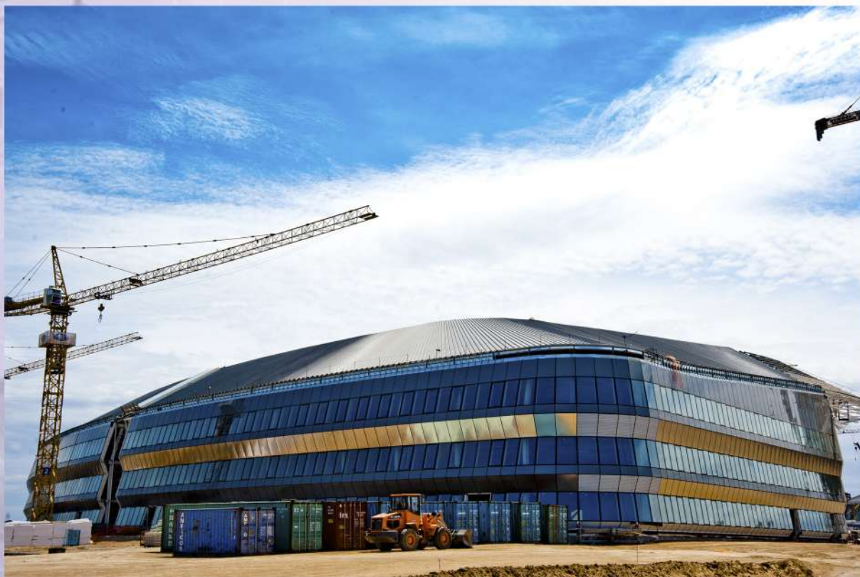
Общий вид павильонов блока С под общей кровлей
