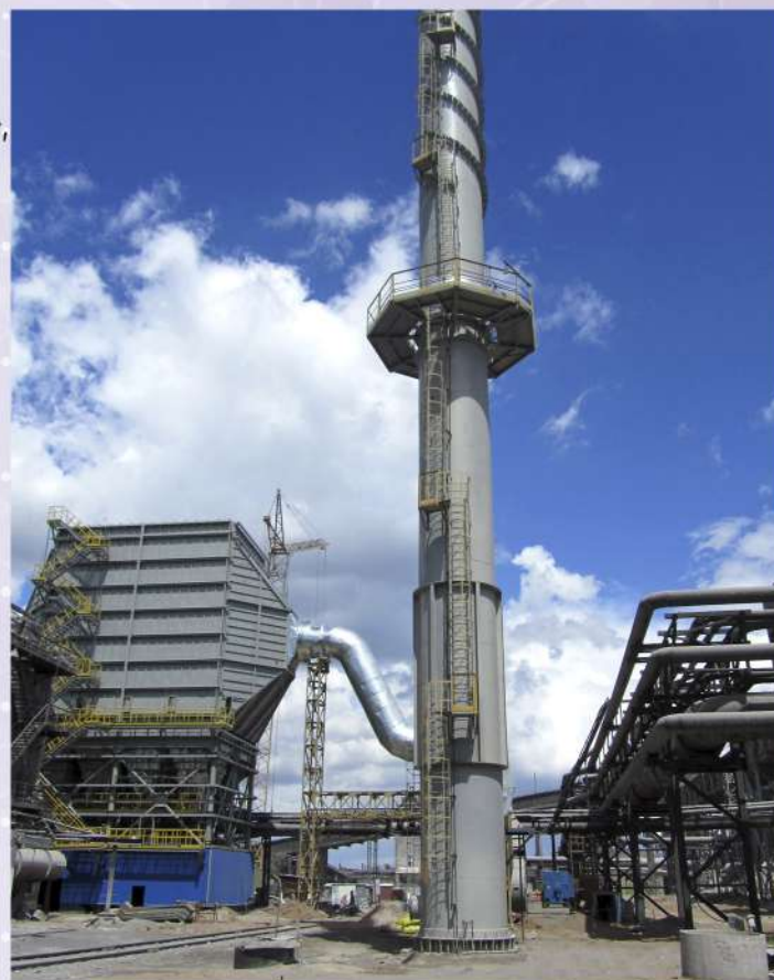
Цех обжига известняка. Газоочистка. АО «ArcelorMittal Temirtau»
