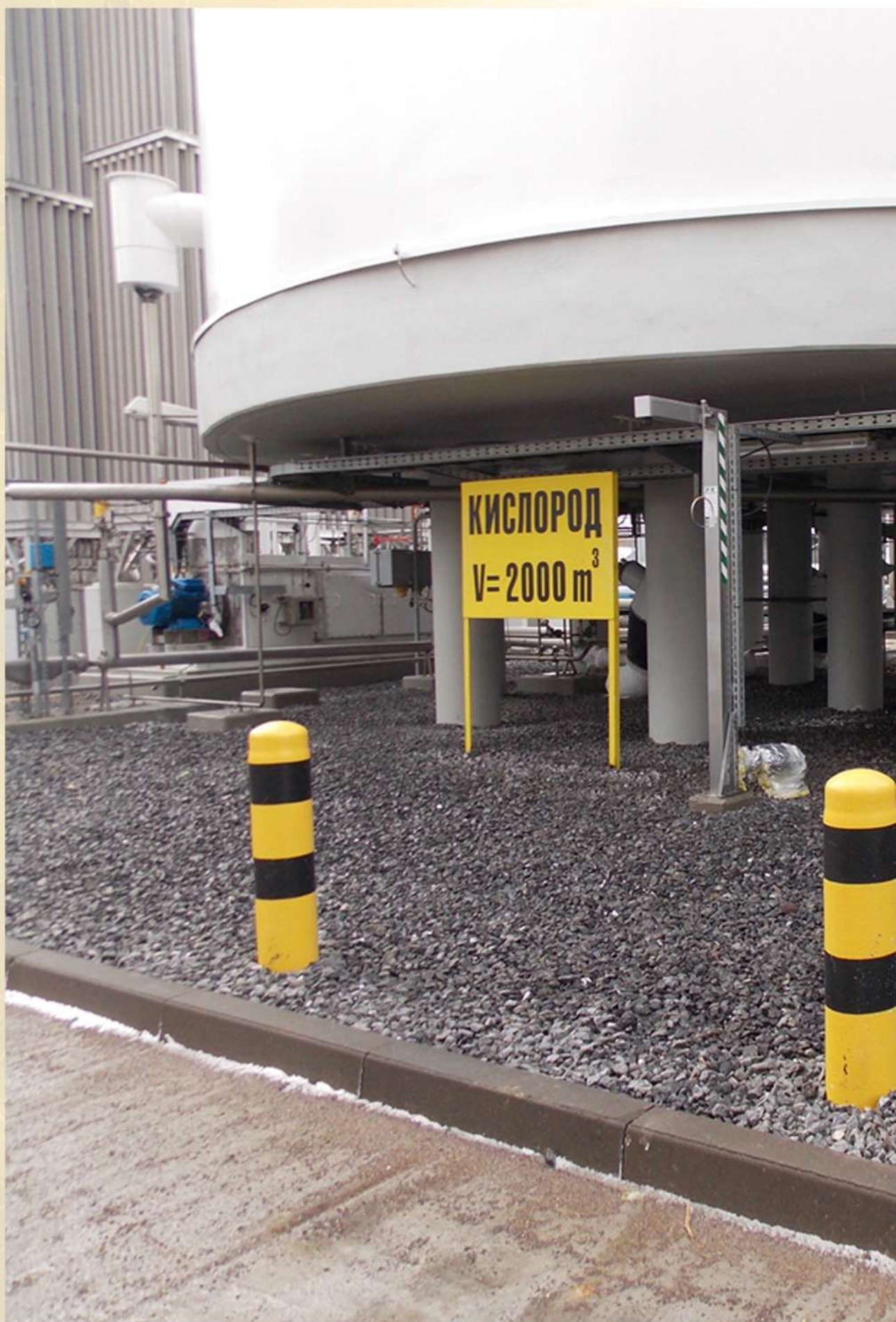
Фундаменты под резервуары. Воздухоразделительная установка, ТОО «Linde GLS Kazakhstan»
