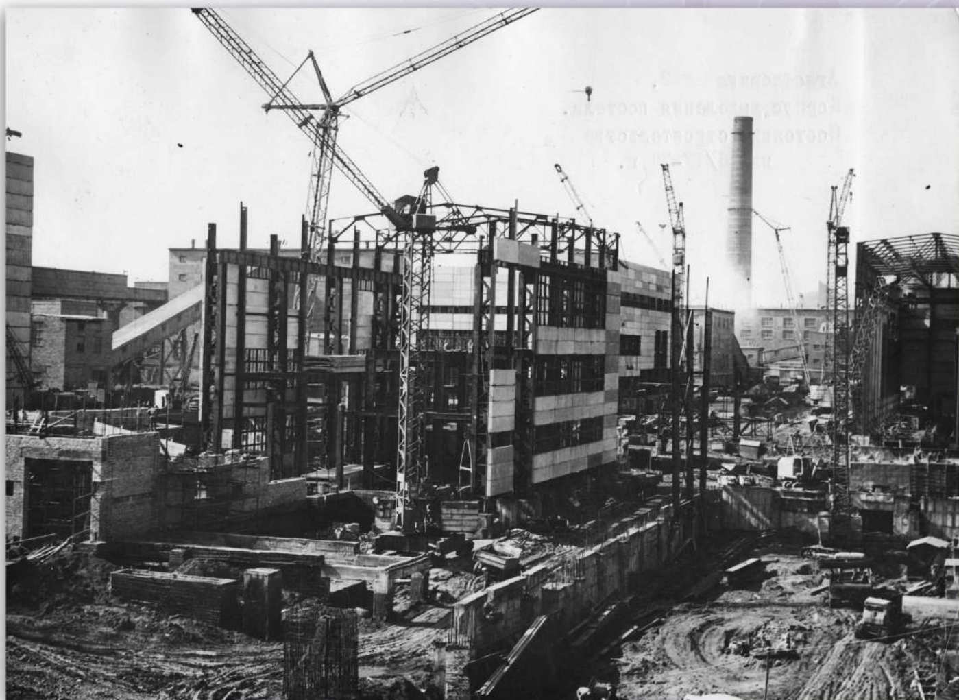
Архив. Строительство аглофабрики №2, КарМетКомбинат, г. Темиртау.
