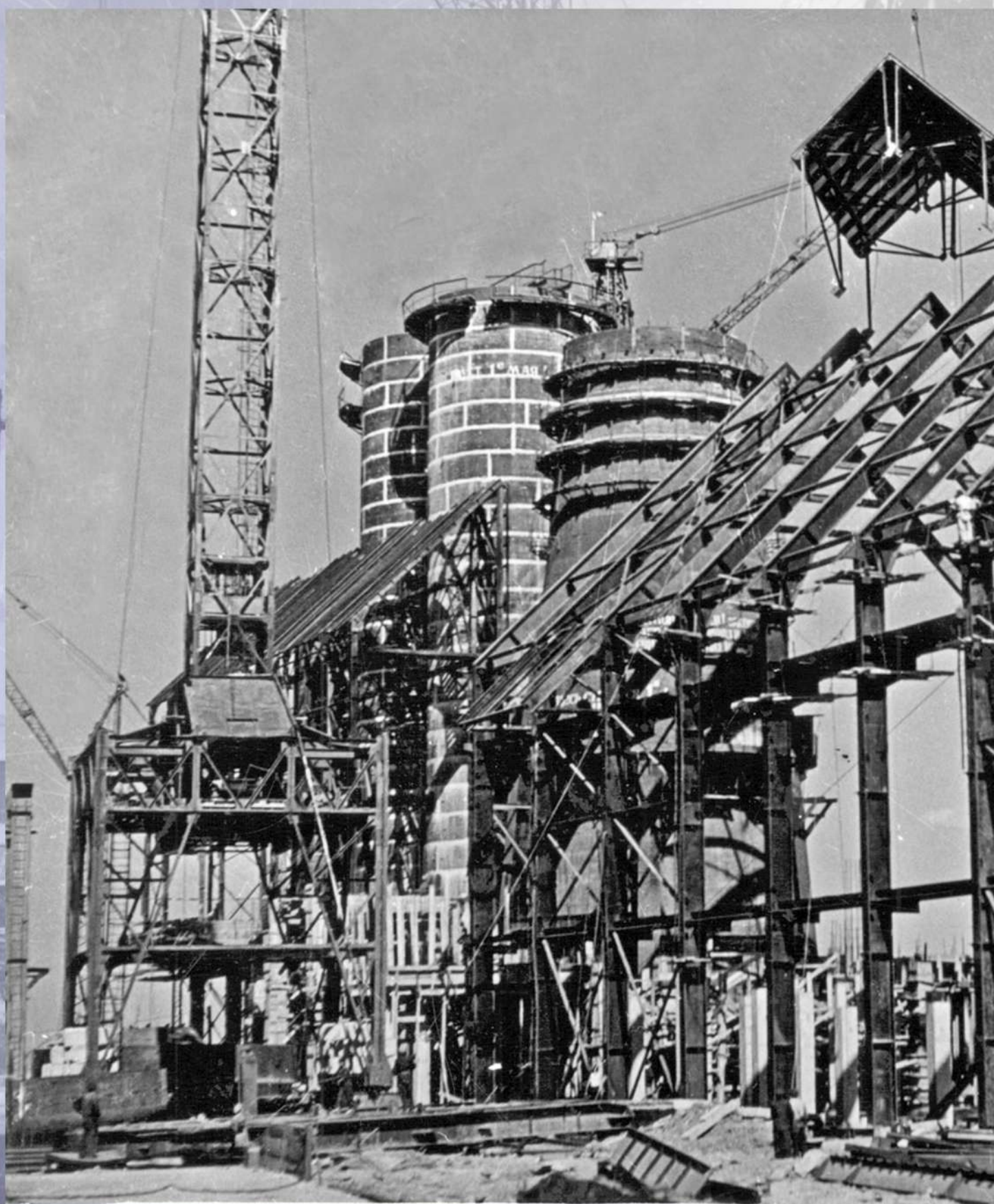
Архив. Доменная печь №1, КарМетКомбинат, г. Темиртау
