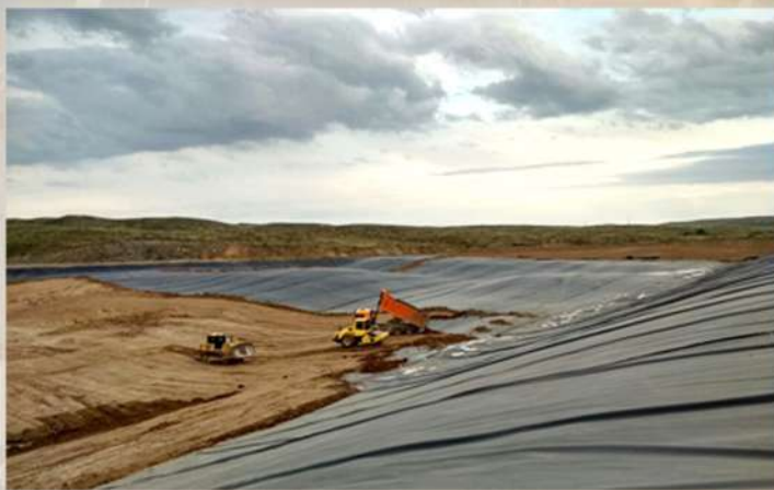
Устройство защитного слоя по геомембране. Хвостохранилище ТОО «Вакрычкское горнодобывающее предприятие»,
