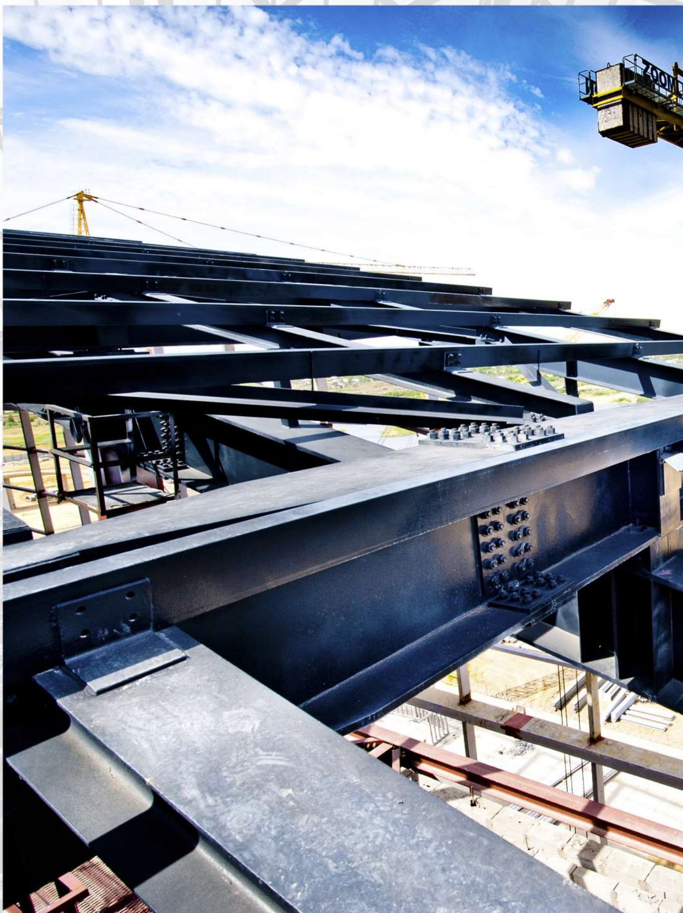
Кровля железнодорожного вокзала в г. Астана
