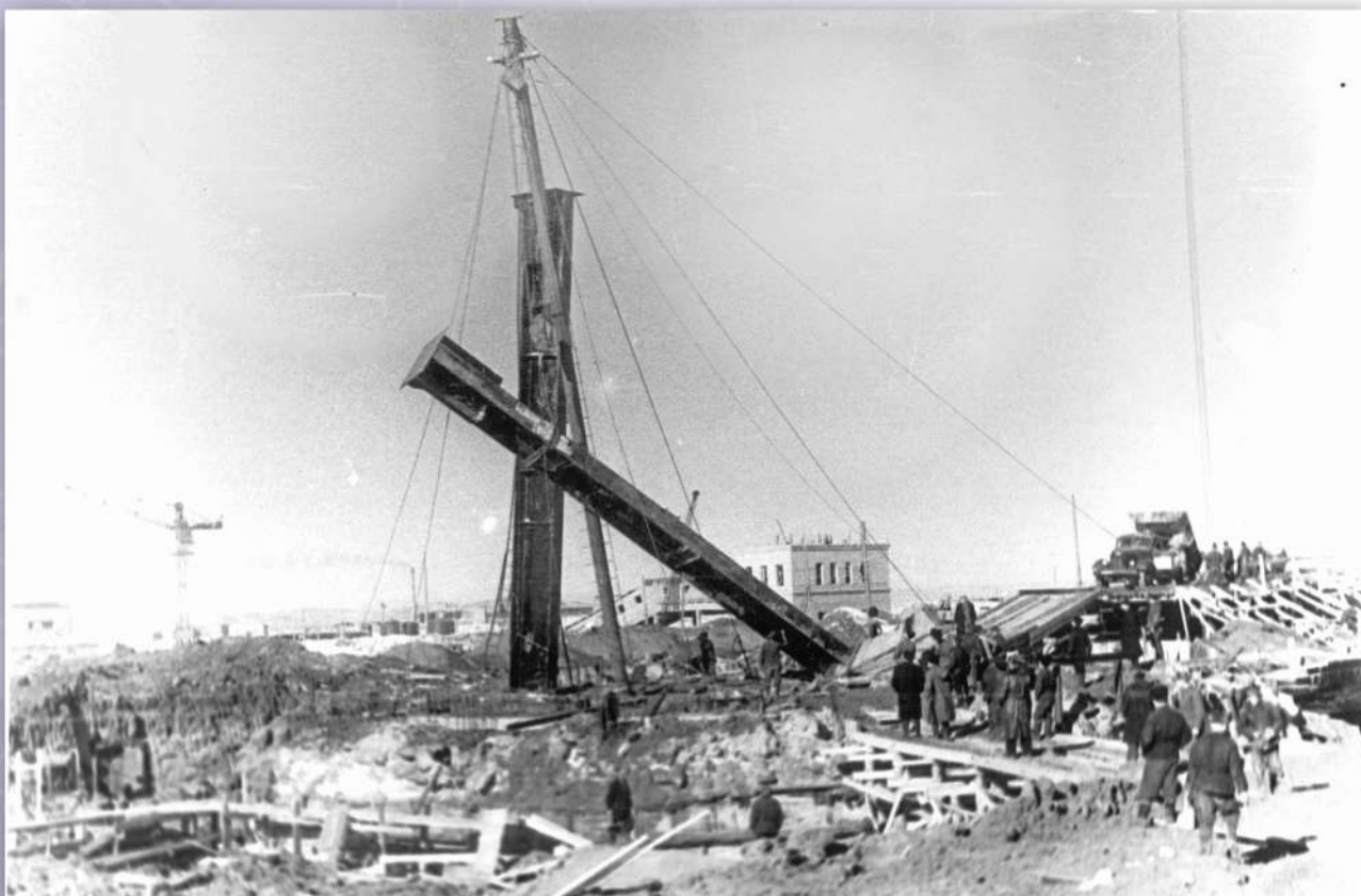
Архив. Карагандинский металлургический комбинат. Монтаж колонн горна домны № 1
