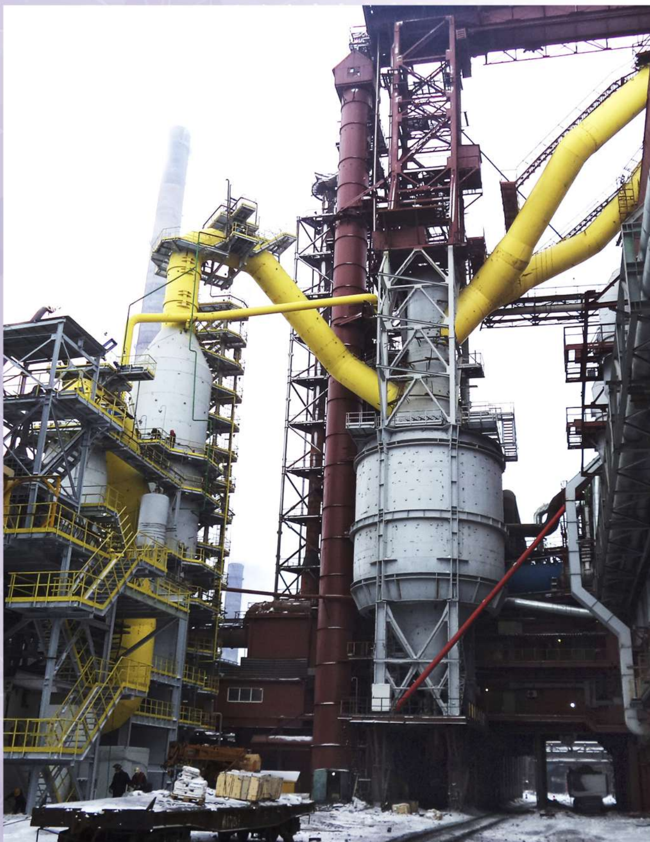
Капитальный ремонт Доменной печи № 3 АО «ArcelorMittal Temirtau»
